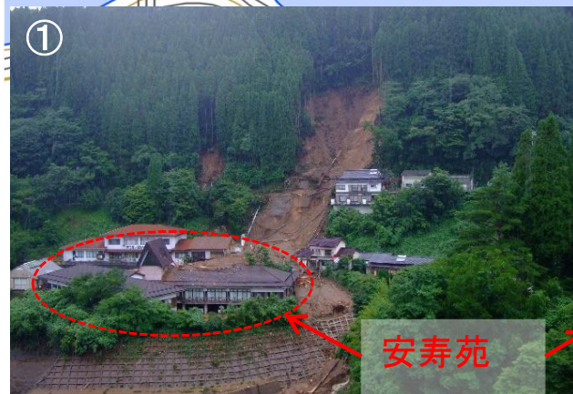
施設周辺の土砂災害の発生状況
