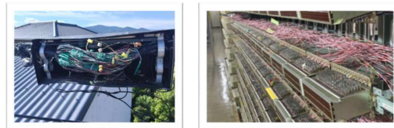
局外収容装置老朽化の事例 (RT-BOXサビ、倒木等)
