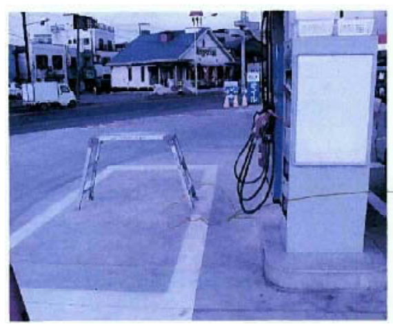
図 4-7 固定給油設備
