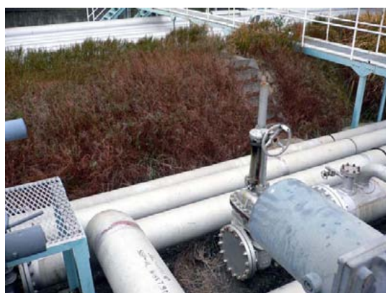
写真 3-1-4 ETBE とガソリンの合流部
