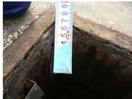
写真 4-1-24 ペーストによる水位測定
