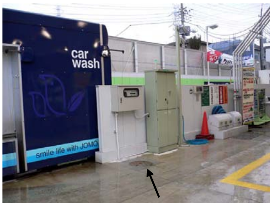
写真 3-1-11 土中センサー設置箇所
