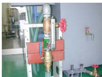
No. 3 バイオマス燃料(ETBE)及びE3の 油分離槽の排水に関する検証試験 試験装置概要 ■流量計と流量調整バルブ ※注水試験時の流量コントロールを行います。
