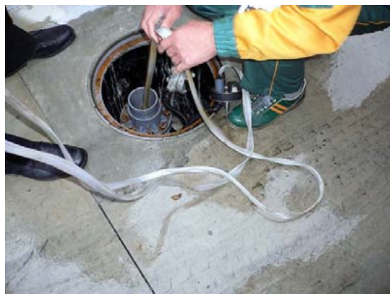
写真 3-1-12 土中センサー（地下水タイプ）
