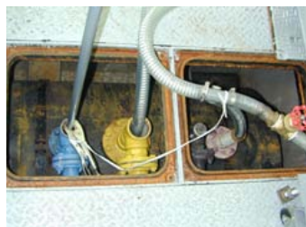
No. 5 バイオマス燃料(ETBE)及びE3の 油分離槽の排水に関する検証試験 試験装置概要 ■排水用1KL地下タンク(鋼製地下タンク) ※排水槽から排出される水を一時貯めます。
