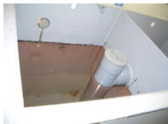
No. 30 バイオマス燃料(ETBE)及びFE3の 油分離槽の排水に関する検証試験 試験状況(ETBE 流速60L) ■ETBE含有がリン3cm通水 前の第1槽の水面
