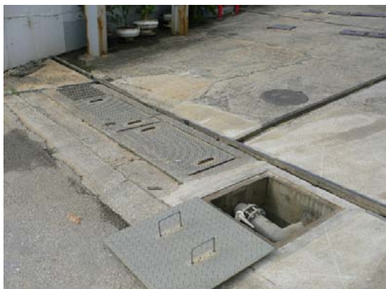
写真 4-1-19 油分離槽
