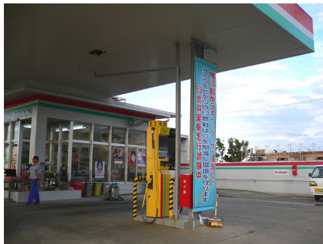
写真 4-1-14 宮古島 E3 給油取扱所全景
