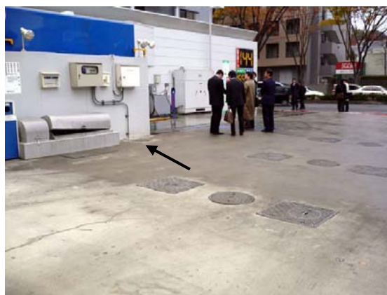
写真 3-1-14 土中センサー設置箇所
