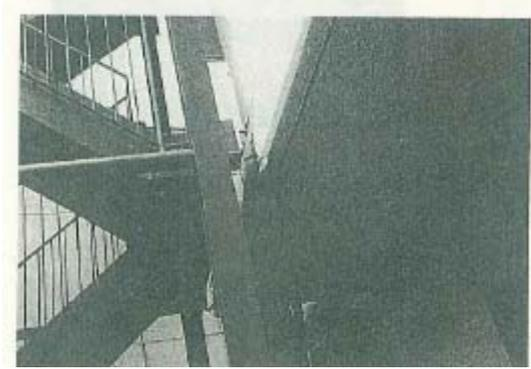
写真6 階段室の破損状況
