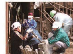
崩れた土壁の片付けをしている様子（石川県輪島市） 写真提供：黒澤司
