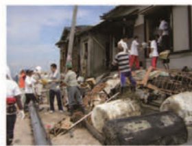
家屋内の片付けをしている様子(広島県呉市) 写真提供: 呉市社会福祉協議会
