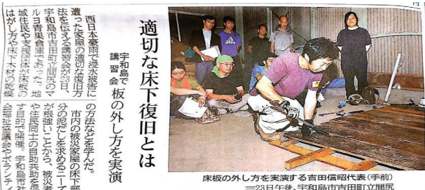
床板の外し方を実演する吉田信昭代表(手前) 23日午後、宇和島市吉田町立開成
