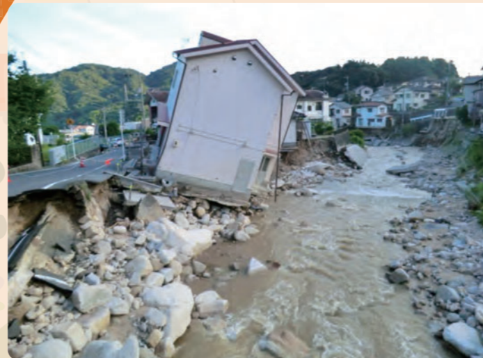
■ 土石流で被災した家屋（安佐北区口田南）
