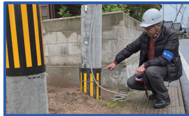
能登半島地震で液状化による電柱の沈下を現地調査する荻本孝久名誉塾長
