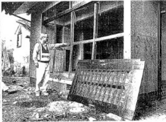
豪雨で倒壊した総社市下原地区の建物。川田さんが指す通り浸水した。
