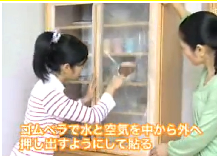
ガラス飛散防止フィルムの貼り付け
