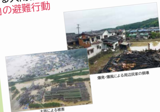
大雨による被害
