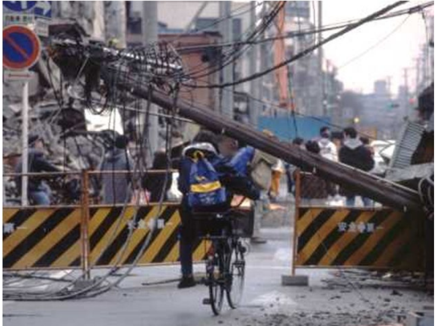
電柱の倒壊
