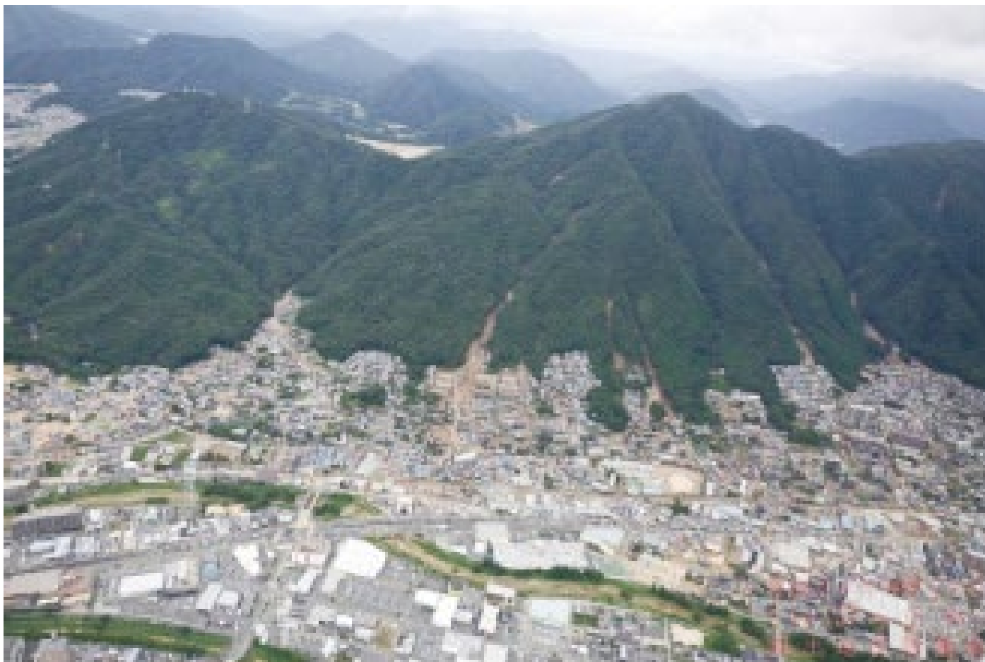
広島市安佐南区上空からの被害状況 (国土地理院提供)
