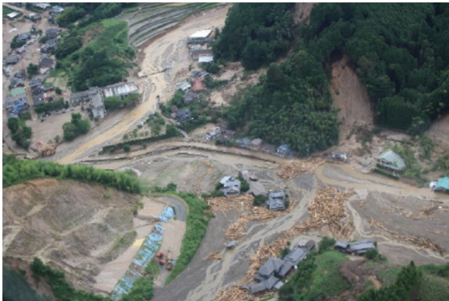
朝倉市松末地区の被害状況 (兵庫県消防防災航空隊提供)
