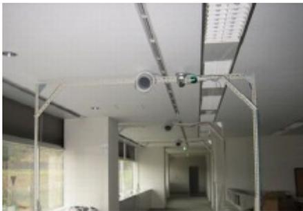
図 - 7 光、音誘導装置設置状況
