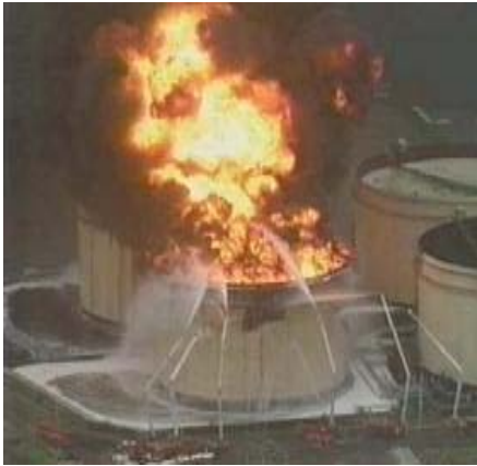
石油タンク全面火災
