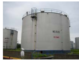
写真-1 1600KL インナーフロートタンク
