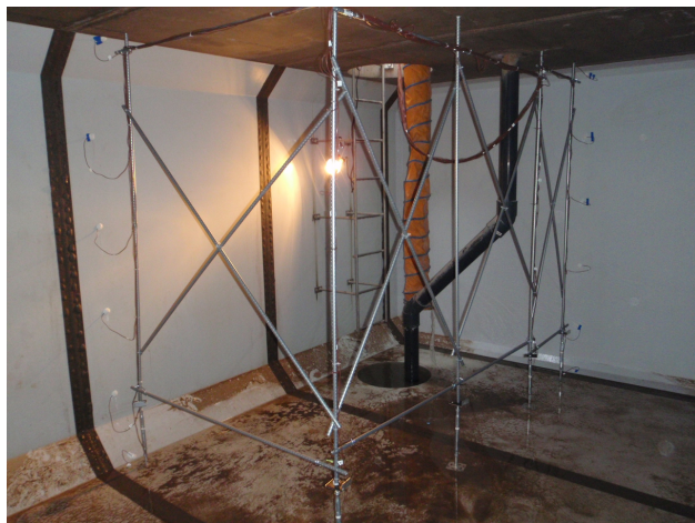
写真.2 防火水槽内における熱伝対の設置様子
