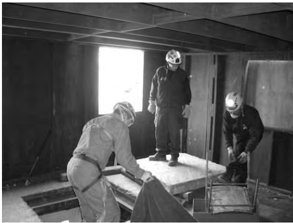
2階のコンクリート片を除去し、1階へ進入する。
