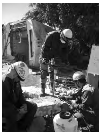
コアドリルで穴を開け、内部を確認する。
