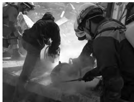
下書きに沿ってエンジンカッターで切断していく。
