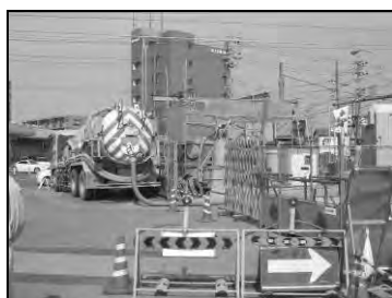
下水道工事現場
