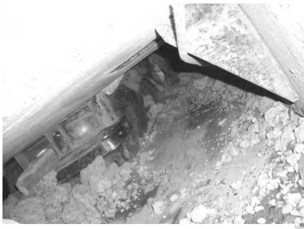
Rescue Systems2 の狭隘な空間、車両が押し潰されて空間を作っている。
