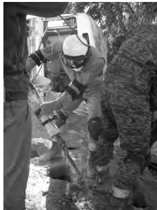
さらにハンマードリルで崩して、周りの強度を弱める。
