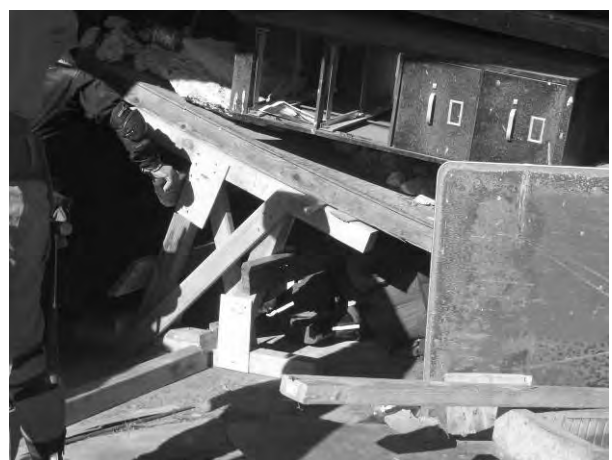
倒壊家屋のボイド（空間）に対して設定を行うショアリング、クラスⅢである。
