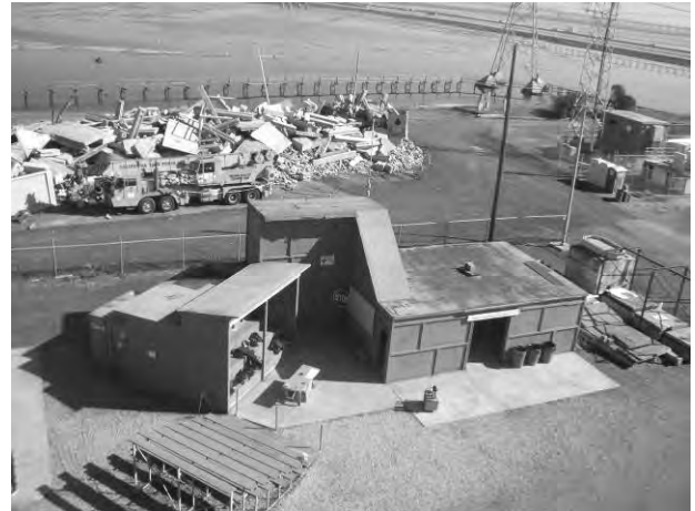
高所タワーから撮影した訓練施設、クレーンの奥に瓦礫の訓練施設が見える。
