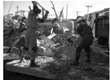
強度が落ちたところで、ハンマーで叩き、穴を開ける。
