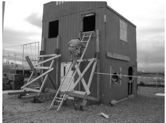
屋外から建物を固定するレイカー・ショアが施されたあと梯子を架梯し、開口部にウインド・ショアを施している。
