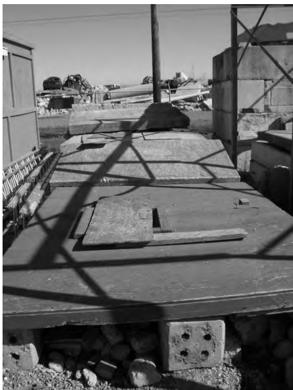
トンネリングの施設で、このように板を被せた状態で行い、手前から瓦礫を取り除き進んでいく。
