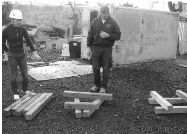
クリビングの基本的な形、右から2×2、トライアングル、ソリッドである。
