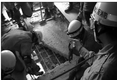
鉄筋カッターにて切断
