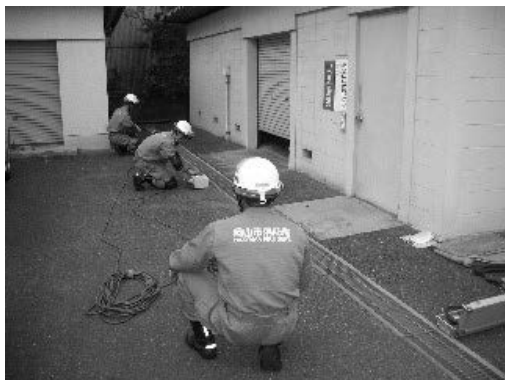
①地震警報器設置
