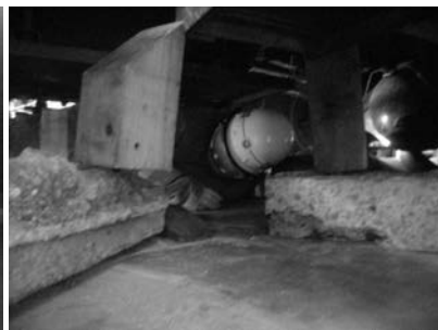
confined space での簡易ショアリング
