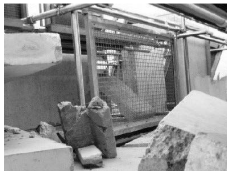
取り外し可能な仕切り
