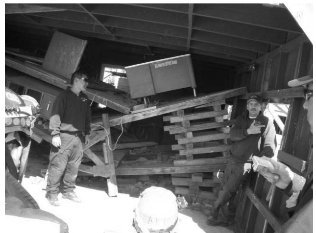
建物の倒壊等で出来たボイド(空間)をクリブで安定させている
