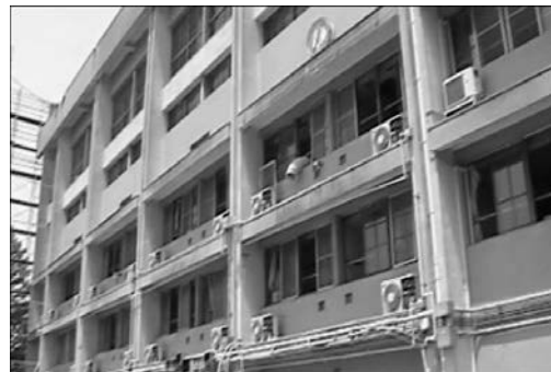
排煙機設定状況
