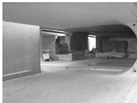
可変側溝による空間
