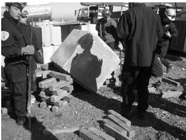
サイコロ状のコンクリート片を転がす際も、クリビングで安定出来る
