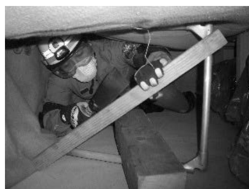
⑥障害物除去状況
