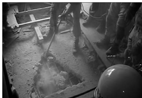
鉄筋が現れる
