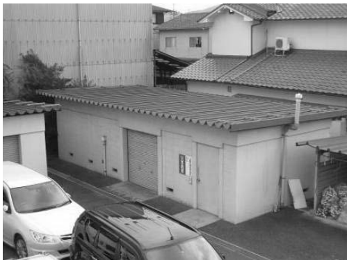
① 倉庫の全景
