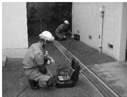
②電磁波探査装置での検索状況
