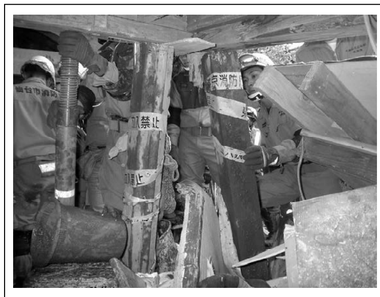
写真2 ショアリング設定状況
