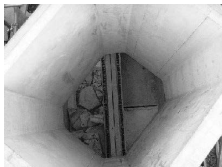
ボックスカルバートによる縦空間
