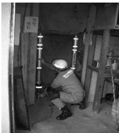
⑤支柱器具によるショアリング状況
