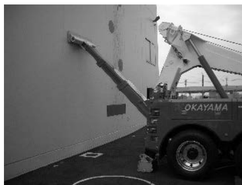
② レッキング装置によるショアリング実施状況
