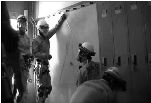
下階にて更に側壁を破壊
