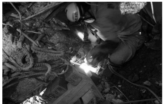
3×3クリビングで重量物を持ち上げている、上部は接点が少ない為、クリブを施している。
