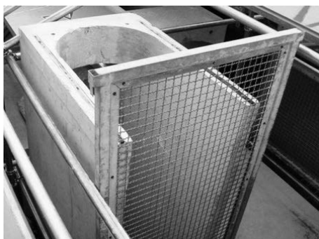
可変側溝による縦空間
