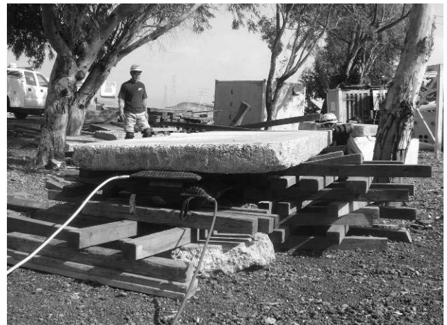
クリブとマット型空気ジャッキで安定した持ち上げ作業中のコンクリート板
