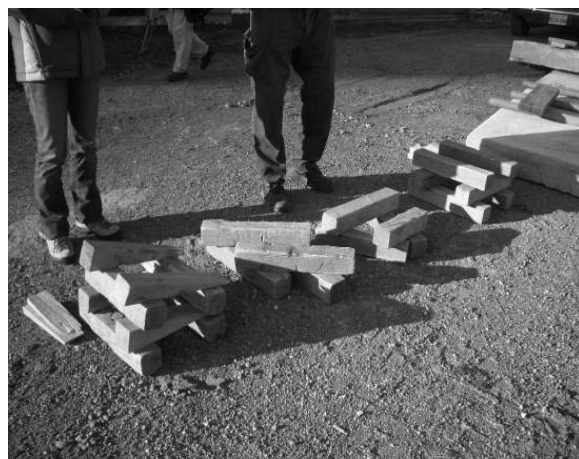
基本的なクリブの組み方
