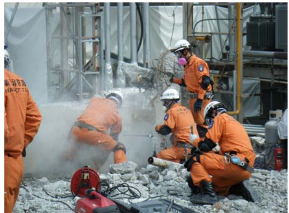
双腕作業機と救助隊員が、同時進行で壁面下部にブリーチングを開始 ブレーカーでは壁面下部に横穴を開けるのは困難
