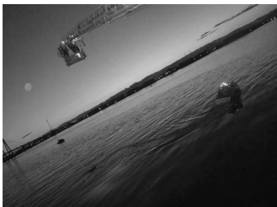
【アンカー設定状況】
