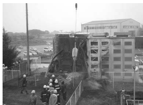
乾燥砂による消火作業
