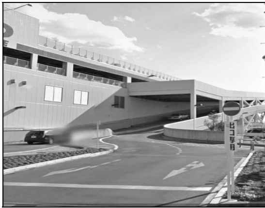
駐車場入口スロープの状況（崩落前）
