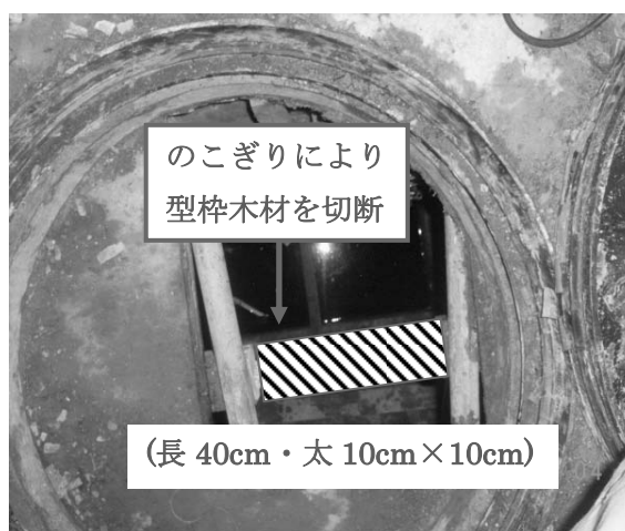
写真5 (地下1階のマンホールの状況)
