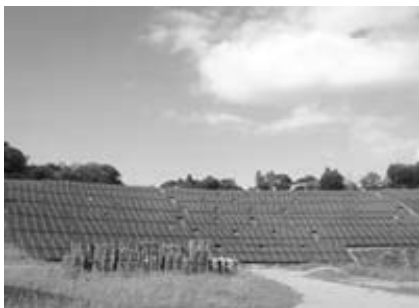
太陽光パネル
