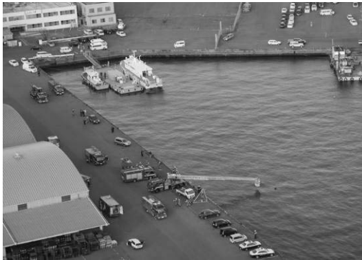
【現場南側上空より撮影】
