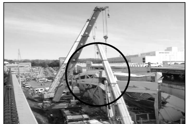
大型重機による崩落防止処置の状況
