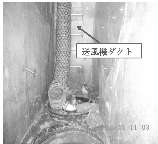
写真3 (送風機を投入した状況)
