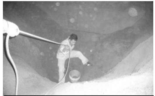
砂排出中の作業員を救助ロープで引き上げている状況
