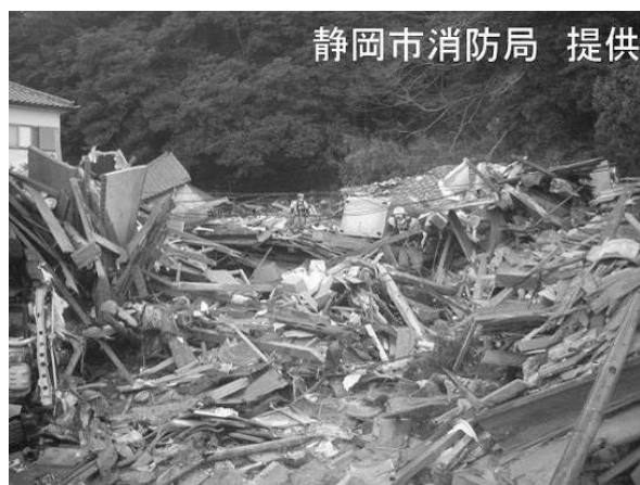
津波で流された建物の搜索状況 （消防庁 HP より）
