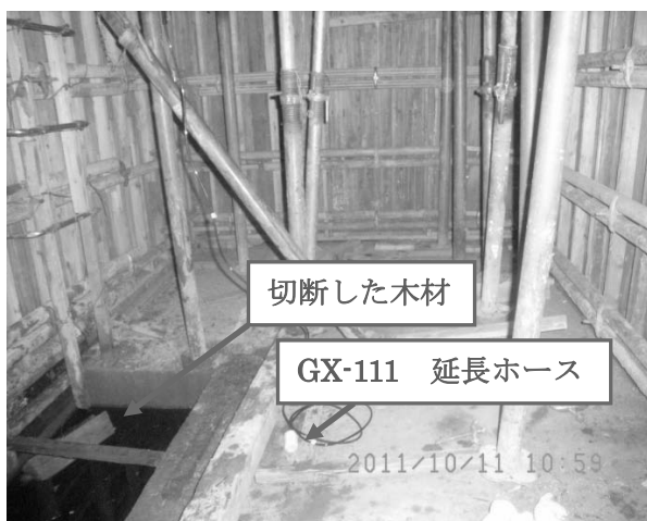
写真4 (地下2階ピット内の状況)
