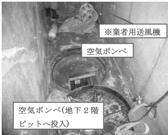
写真2 (空気ポンベを投入した状況)
