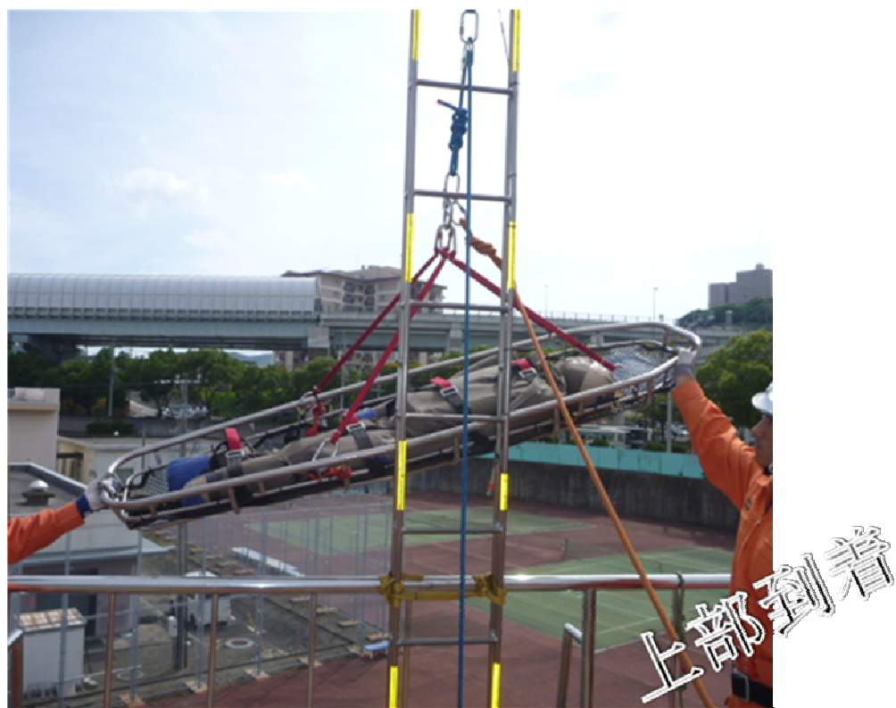
引き揚げを実施し上部支点まで到着
