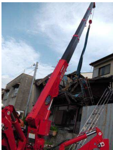
崩落住宅の固定状況〈図－5〉
