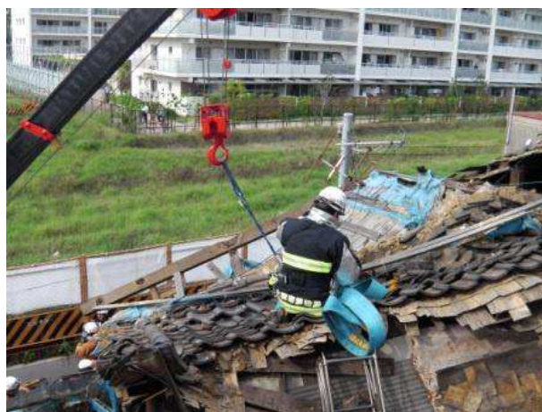
崩落住宅の固定状況〈図－5〉
