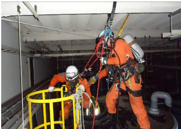
【貯留タンク内での酸欠事故】
