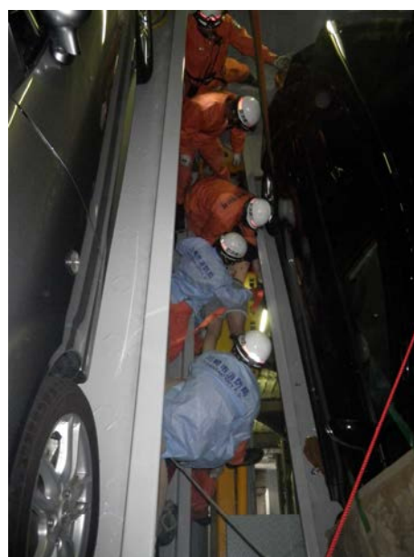
マット型空気ジャッキ設定状況
