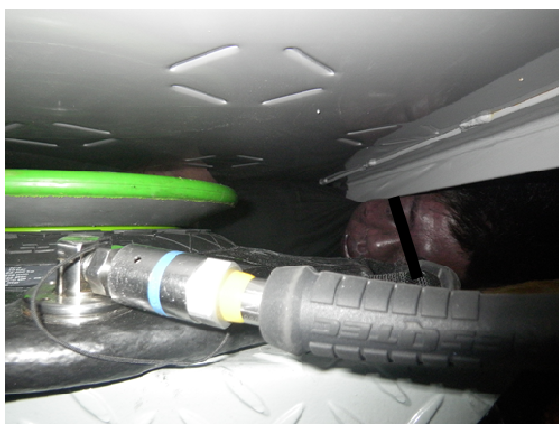
マット型空気ジャッキ設定状況
