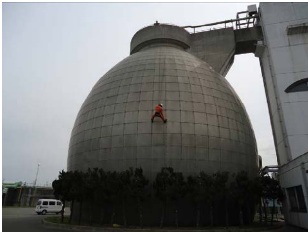
【浄化センター卵形消化槽からの降下訓練】
