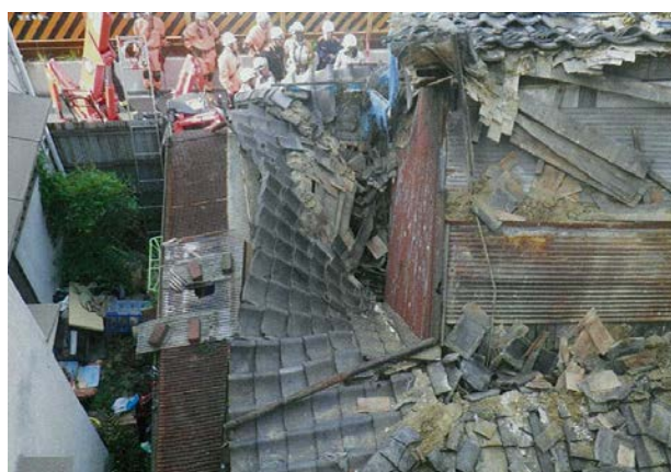
崩落住宅の状況〈図－2〉
