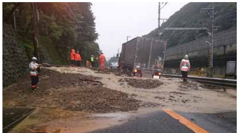
国道1号寸断状況
