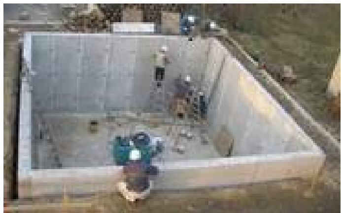
【写真 - 5 地中連続壁】
