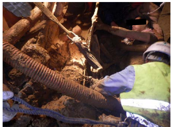
汚泥吸引車による土砂吸引状況
