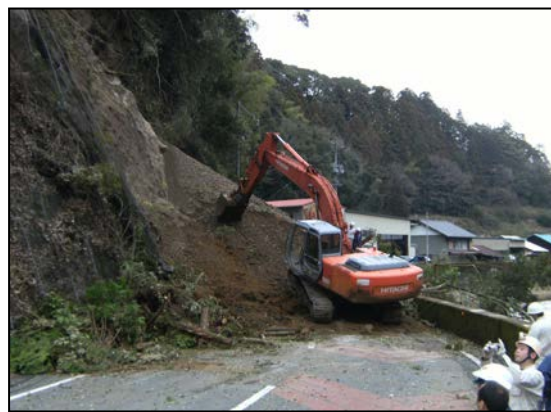
重機による土砂の除去
