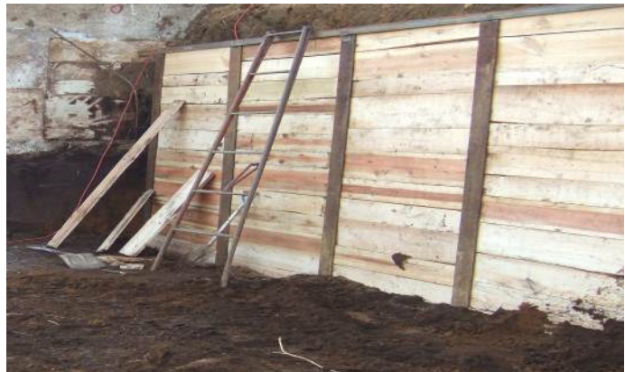
【写真 - 3 親杭横矢板壁】
