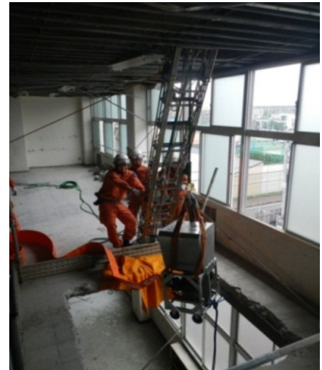
はしごクレーンによるポンプ投入訓練
