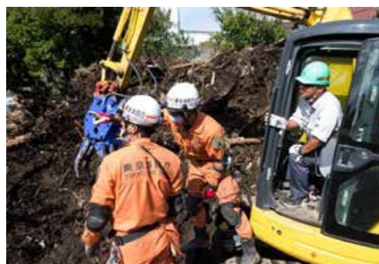
写真6（重機活用状況）
