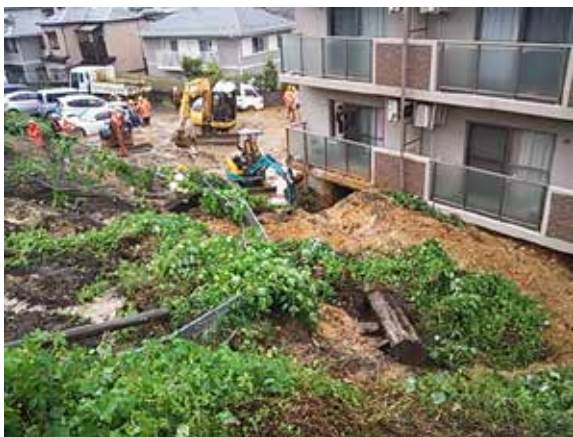
油圧ショベルによる土砂排除状況
