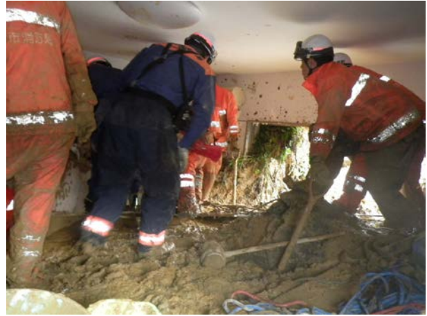
土砂流入状況（屋内から）
