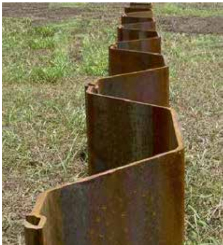
【写真 - 4 鋼矢板壁】
