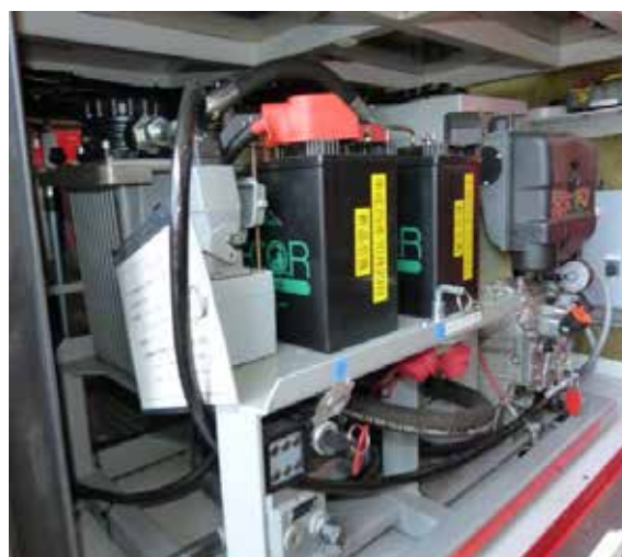
積載写真② (油圧ホース及び水中ポンプ)
