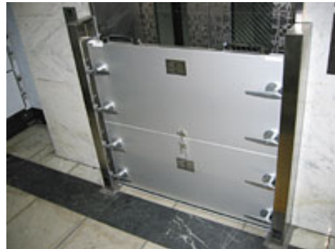
はめ込み式止水板
