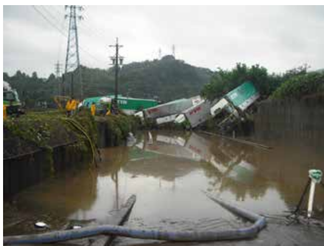
16 日 アンダーパスを東側から撮影
