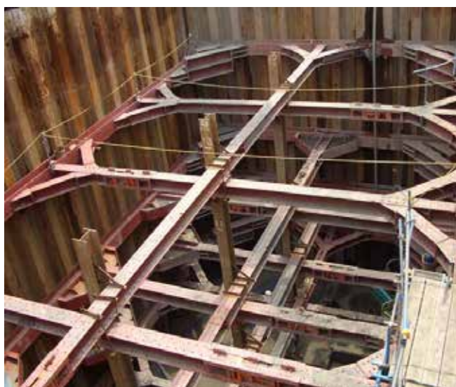
【写真 - 1 土止め支保工】
