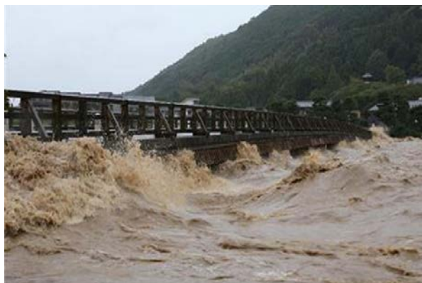
【濁流が打ち寄せる渡月橋の状況】
