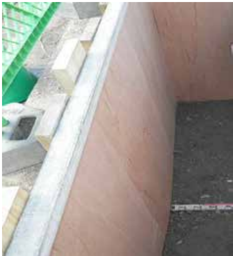
【写真 - 2 簡易土止め壁】
