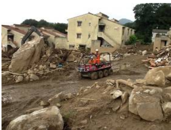
土砂堆積状況での走行
