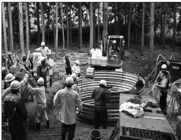
山岳地の地すべり対策用の集中立坑に設置されている階段が崩落し、作業員が立坑内に転落した事故現場。
