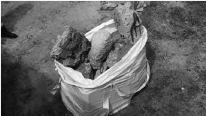
コンクリート片による支点作成
