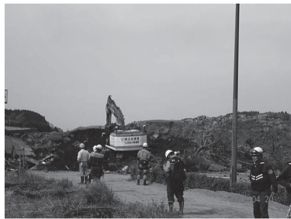
写真8 無人化施工バックホウ作業状況
