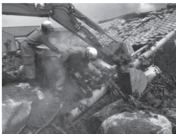
瓦礫除去活動状況
