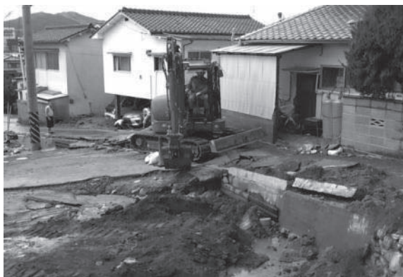
道路啓開活動状況
