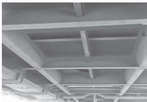
車両下から切断箇所を撮影
