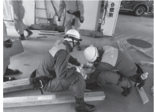
安全区域における釘打ち
