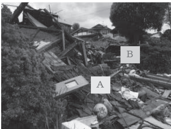
建物西側から撮影
