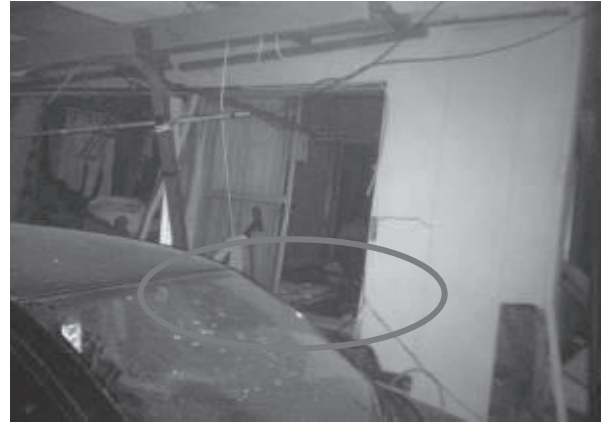
アパート2階床面から下方穿孔
