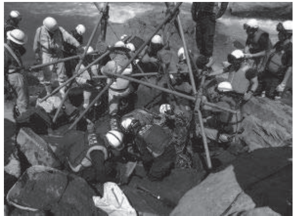
単管パイプで三脚、チェーンブロック設定
