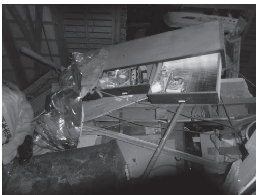
2 階部分の状況
