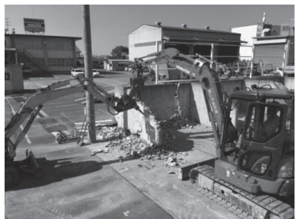
カッター、ブレイカーでの切断訓練
