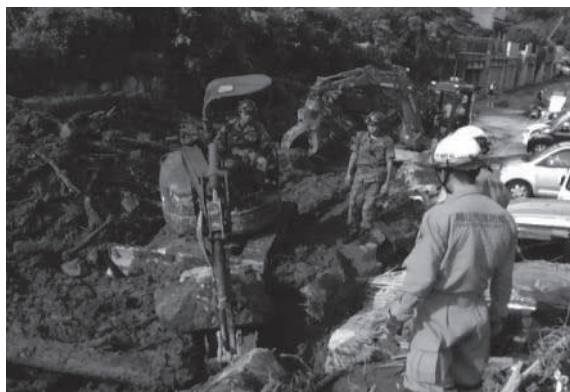
自衛隊との合同瓦礫除去活動状況
