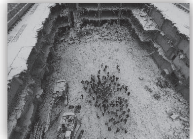
解体中の建物の様子
