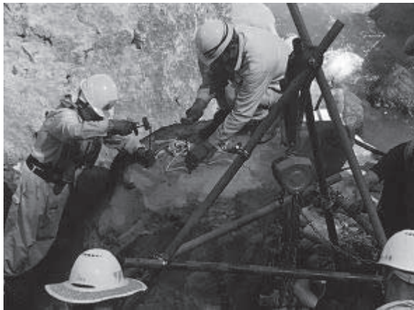
建設業者にて岩体を火薬にて削岩
