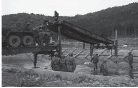
【写真 9：自走架柱橋】
