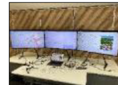
(実際の設置状況)
