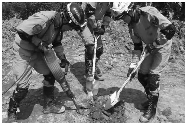
各検証の結果、従来のスコップのみの掘削よりも他の資器材を併用すれば、格段に作業効率が上がることが分かりました。また、それだけではなく電動ハツリ機は資器材としての重量負担がなく、電動仕様であり隊員の疲労度も軽減されるため長時間の作業が可能となります。
