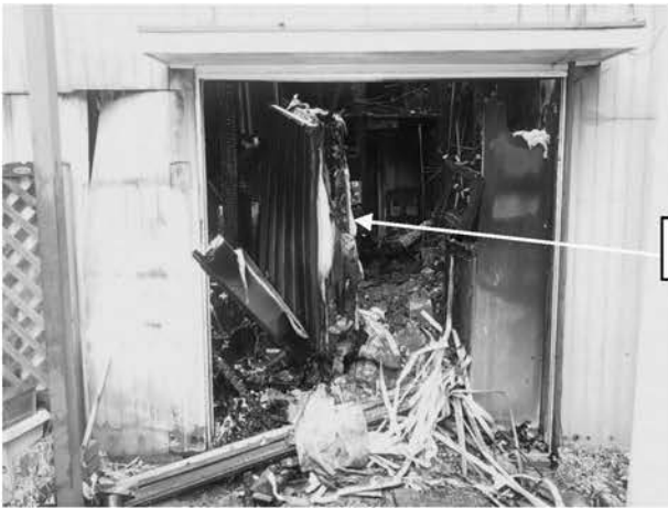
玄関内部の状況
