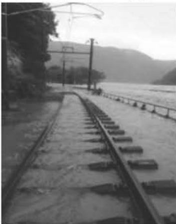
線路から下流方向を見た状況 (右手の柵の右側が国道)
