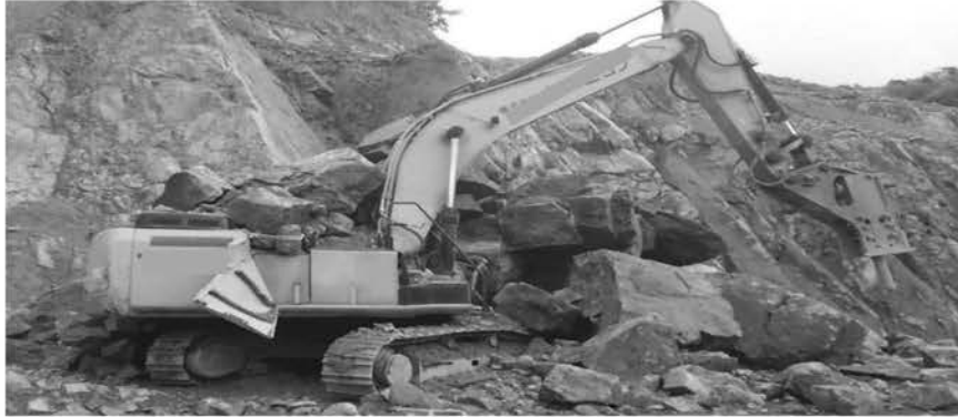
【現場南側より撮影】
