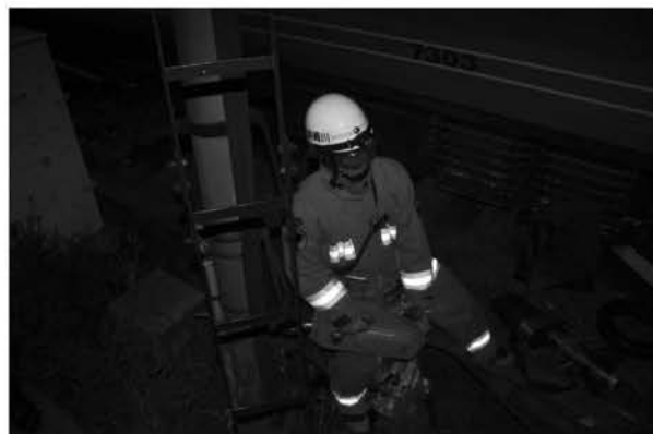
フロント側の支点（電柱）
