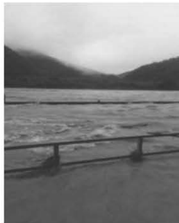
線路から高梁川を見た状況 (手前から線路、国道、高梁川)
