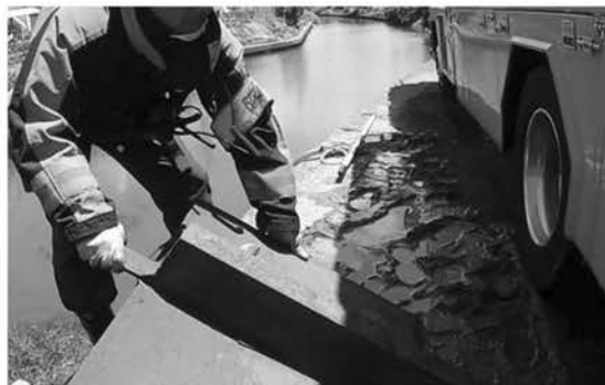
荷重を分散させるために鉄板を敷く状況
