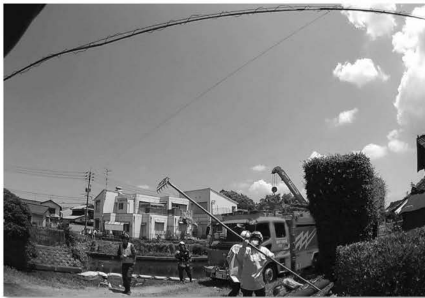
木製の鋏で電線をかわす状況
