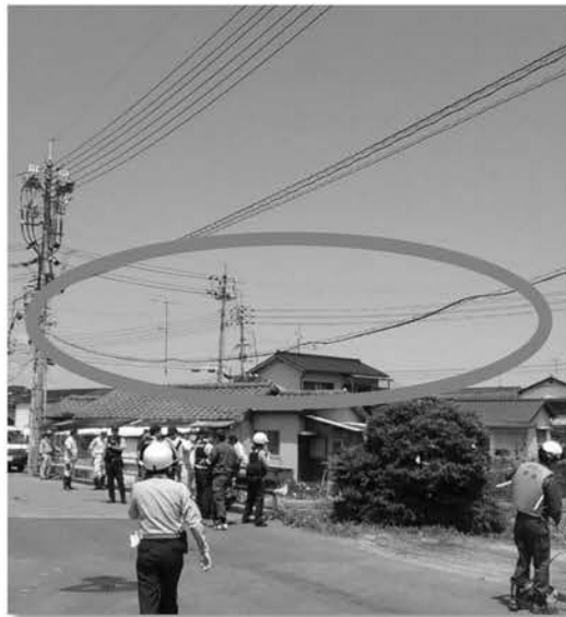
垂れ下がった電線の状況
