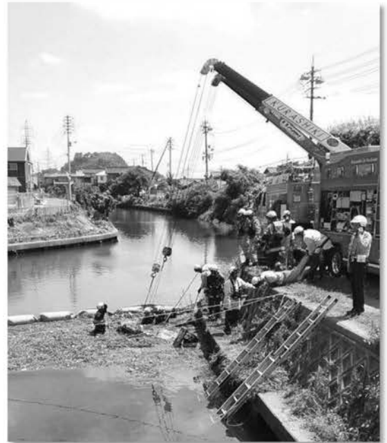
2台のクレーンによる持ち上げの状況
