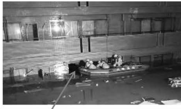
施錠されたベランダ窓を万能オノで小破壊し、開放
