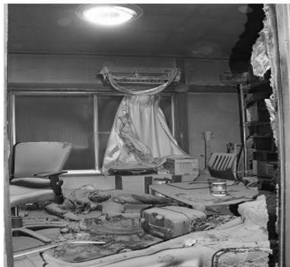
2階洋室の状況
