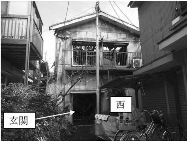
西側玄関の状況
