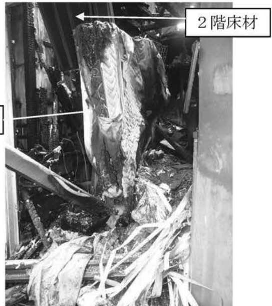
玄関内部の状況
