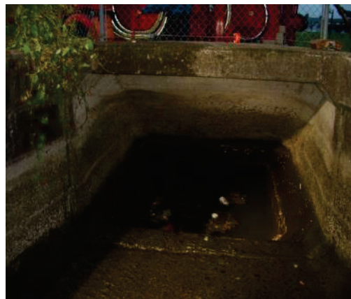
【排水作業中のサイフォン内部】
