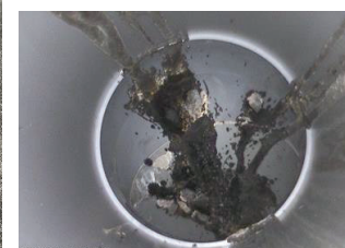
排水溝内部画像
