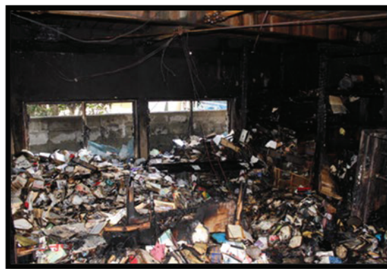
火点室の内部
