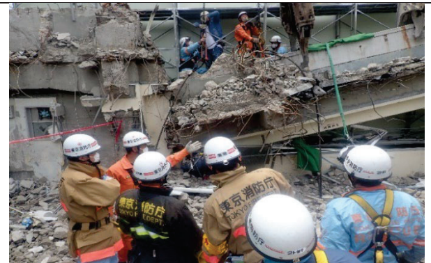
⑧ 壁体への玉掛け作業
