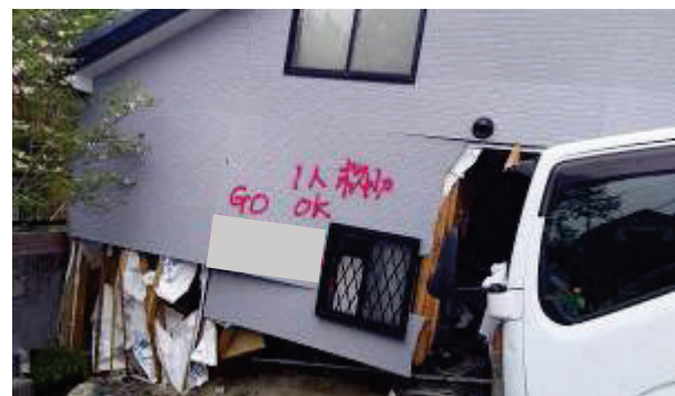
平成28年熊本地震でのマーキング
