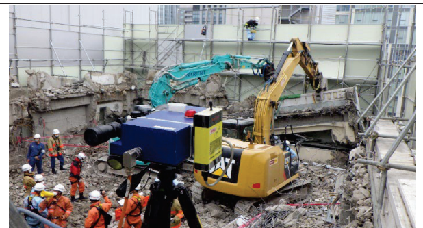
⑥ 即応対処部隊による土砂災害遠隔監視装置の設定状況
