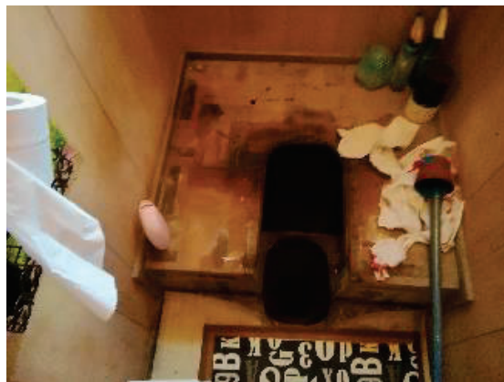
便器を離脱し内部を検索
