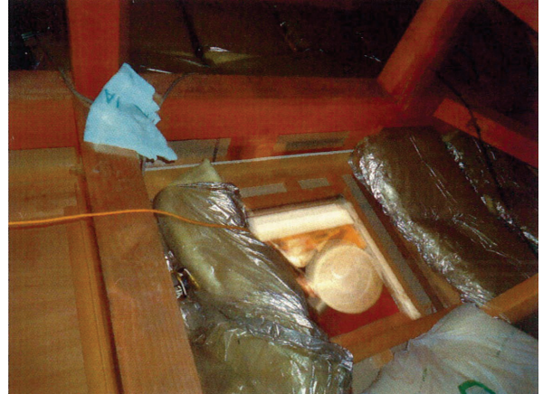
点検口の状況（上から）
