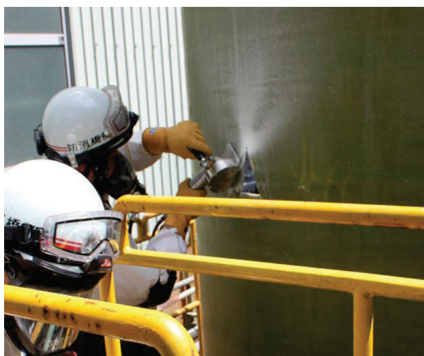
【図5：タンク切断作業】
