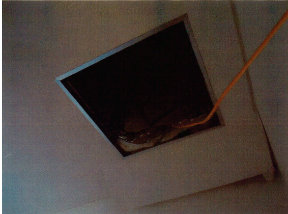
点検口の状況（下から）
