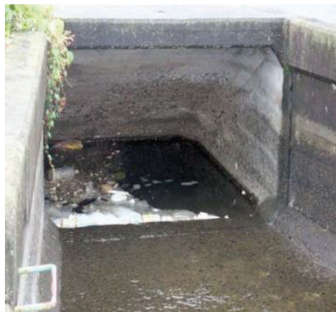
【用水路内サイフォン部の状況】
