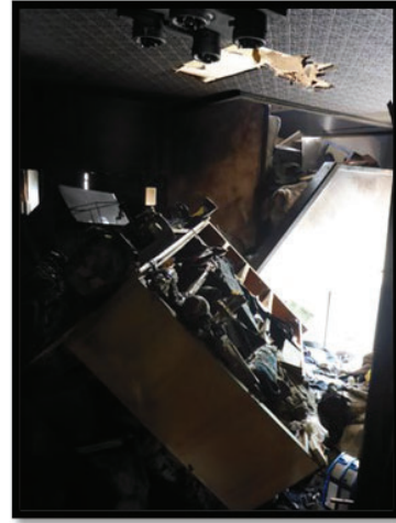
玄関、階段の状況
