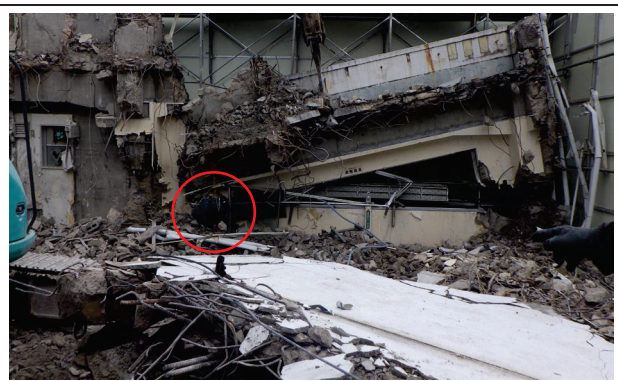
② 先着隊現場到着時の状況
