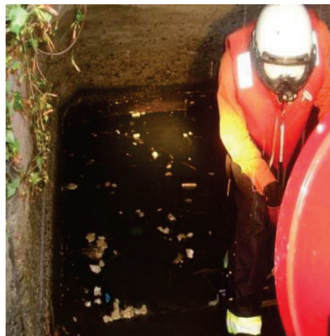
【サイフォン内部を検索している状況】
