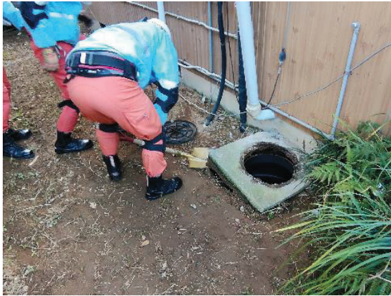
屋外便槽蓋及び枠を離脱
