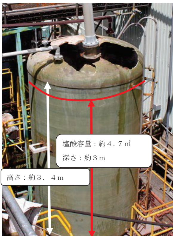
【図1：塩酸タンクの状況】
