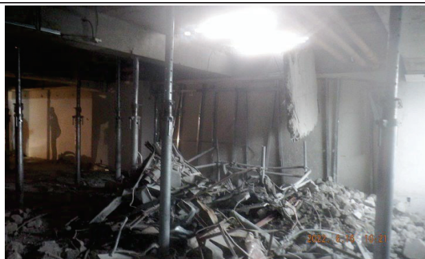
⑦ 8階部分 解体業者によるパイプサポート設定状況
