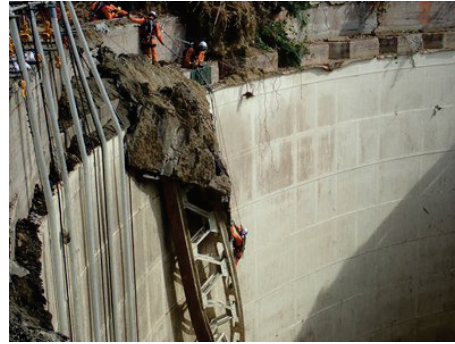
【けん引工作隊によるトラスの固定作業】
