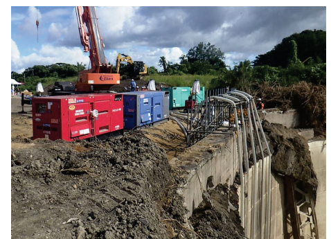
【排水ポンプの設置】
