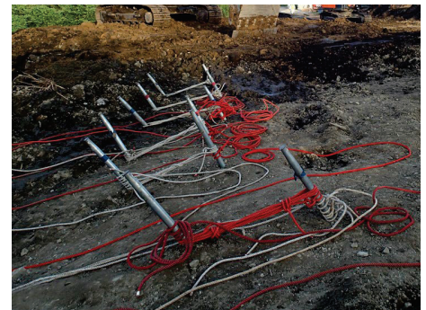
【アンカーの設定状況】
