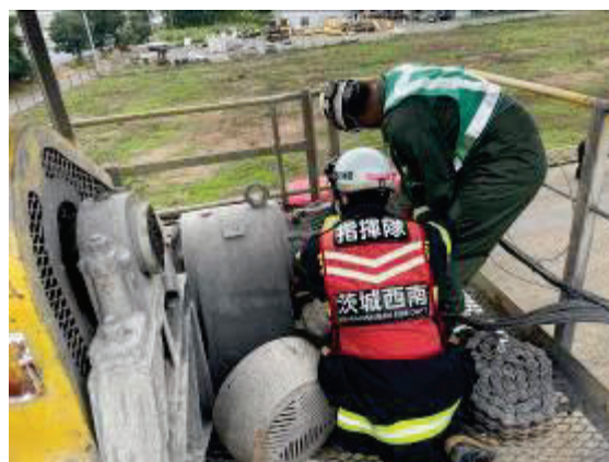
プラント取扱責任者により作動用モーターを操作
