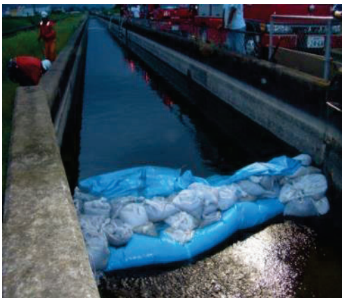
【土嚢によるせき止め状況】
