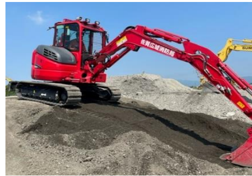
道路啓開（下り）
