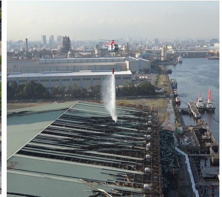
建物火災（市内・空中消火活動）
