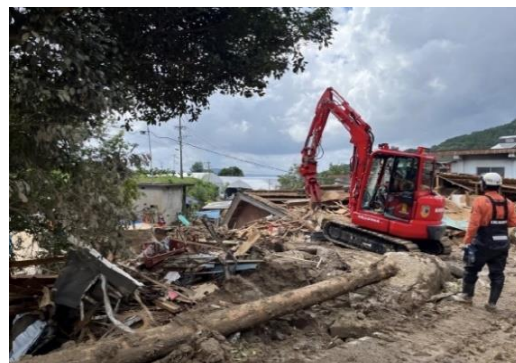
当消防局保有の重機による瓦礫搬出
