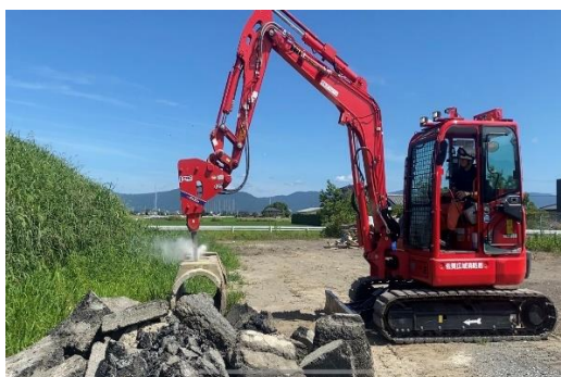
油圧ブレイカーによる破壊要領
