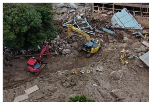
当消防局保有の重機と民間重機の作業状況
