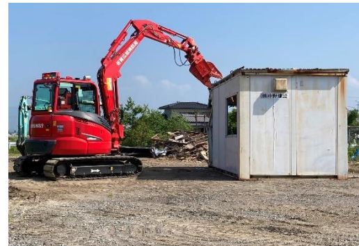
プレハブ小屋解体
