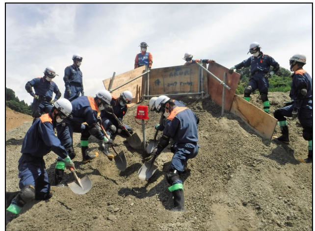
一文字控え杭の様子
