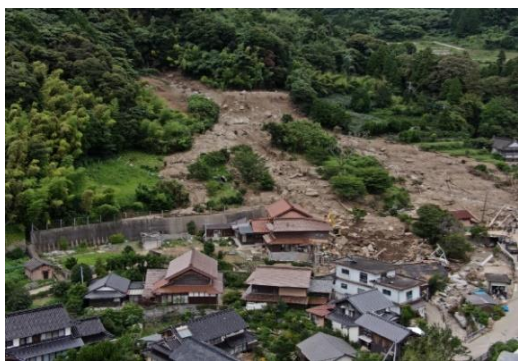
現場全体の被災状況
