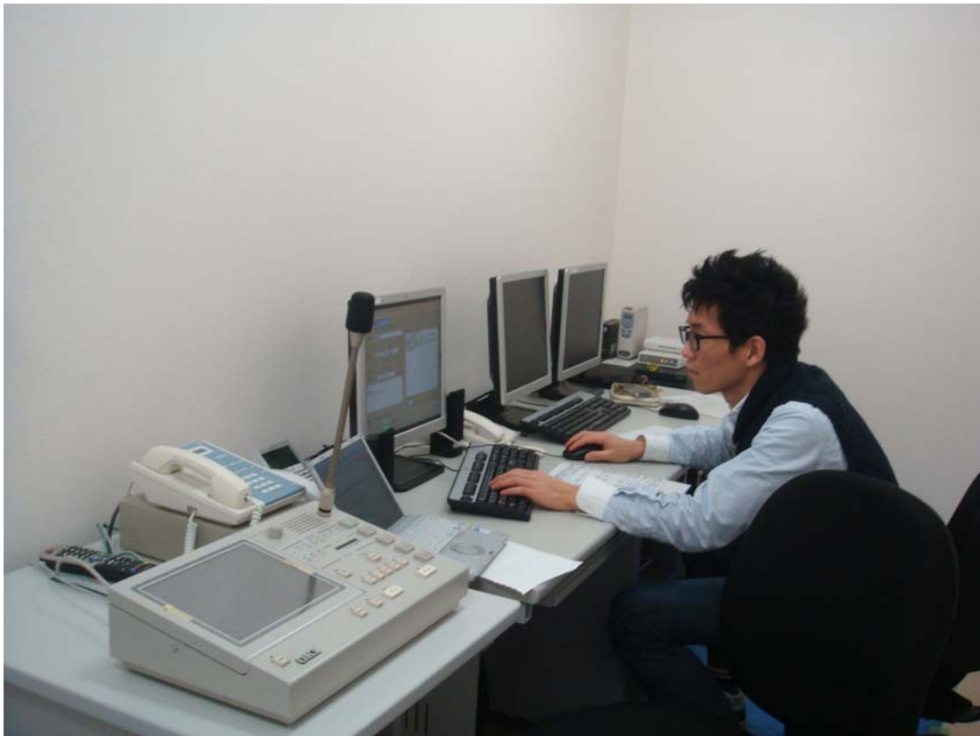
4. 3 4階放送室 自動配信装置端 920MHz 非常電話 アンサーバック監視モニター
