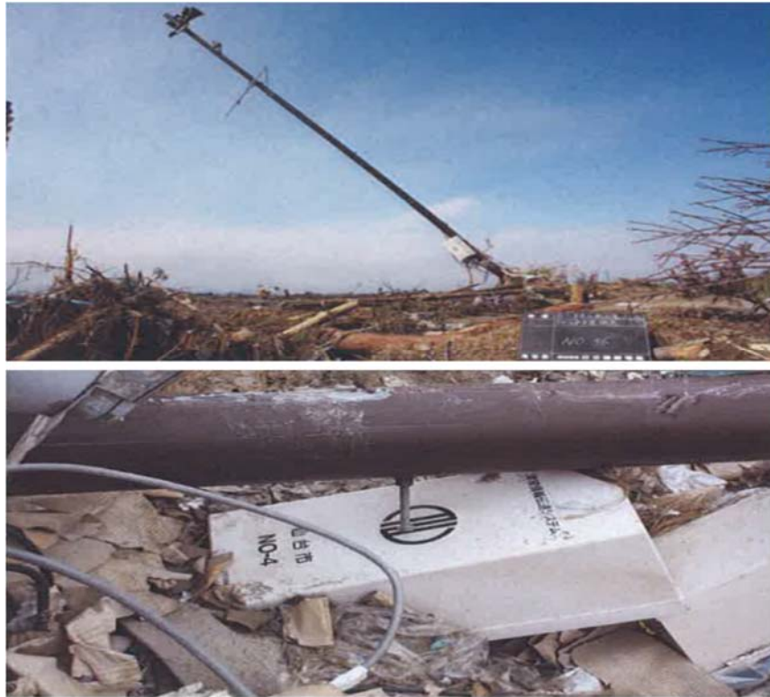
図1 津波により被災した屋外拡声装置
