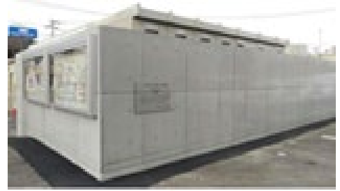
<図 6・防水壁> (出典 常総市提供画像)
