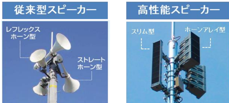
図 39 従来型スピーカーと高性能スピーカーの例
