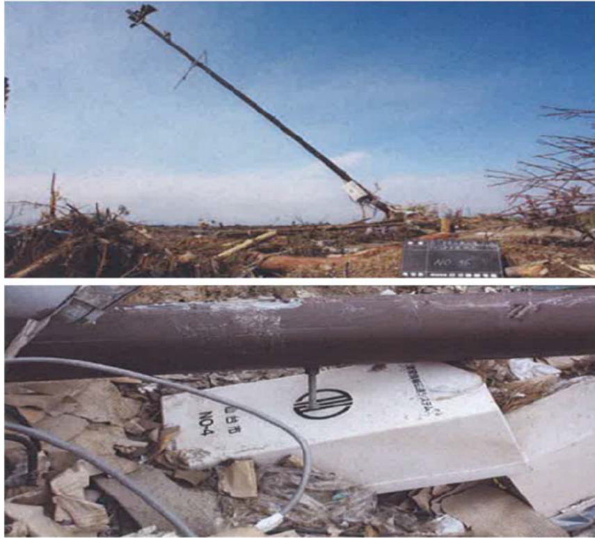
図1 津波により被災した屋外拡声装置
