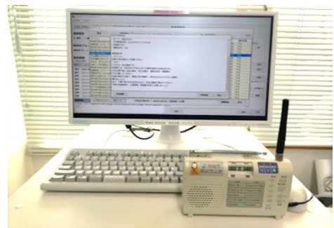
<図1・配信局 操作卓と戸別受信機> (出典 常総市提供画像)
