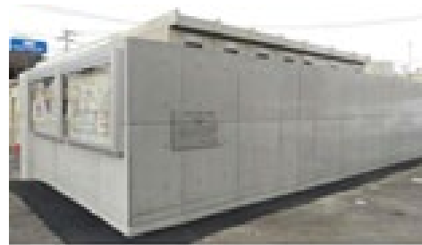
<図 6・防水壁> (出典 常総市提供画像)
