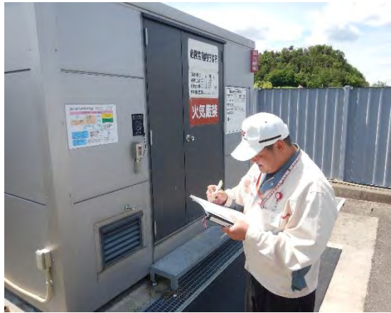
事業所の方が自主点検をしている様子 (屋内貯蔵所)
