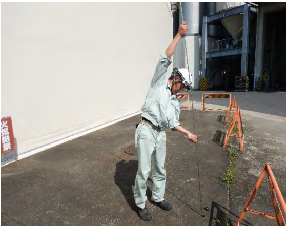
事業所の方が点検をしている様子 (地下タンク貯蔵所)
