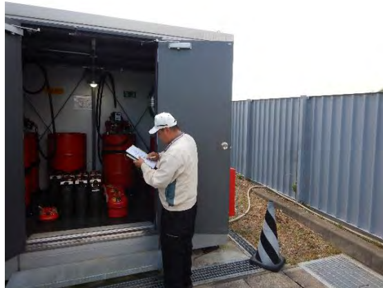
事業所の方が自主点検をしている様子 (屋内貯蔵所)
