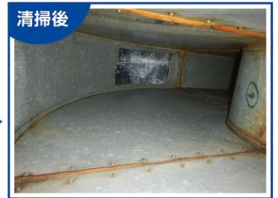
※吸い込み口の風速が弱いとダクトが冷却されず温度が上がってしまい火災になりやすいとのデータがあります。各吸い込み口の風速は設計風量を下回らないようにご注意ください。
