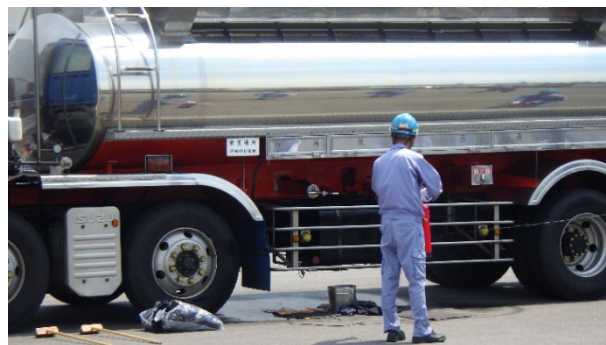
漏えいの処理及び消火器による初期消火
