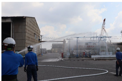
LPGタンクへの放水
