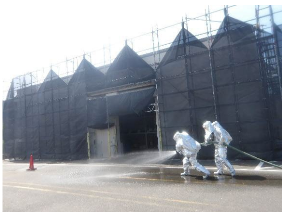
耐熱服を着用した消防隊員による消火活動状況
