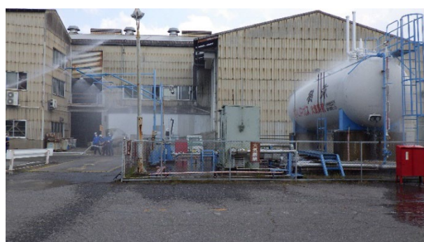
LPGタンクへの放水
