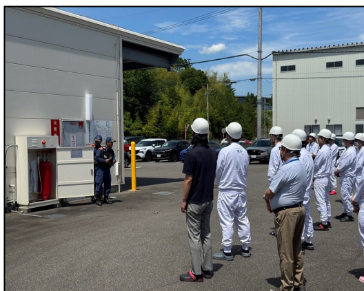
移動式泡消火設備説明
