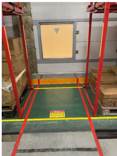
実例(4)エ：非常用進入口の周囲に物品を置いてはいけないことをテープにより明示
