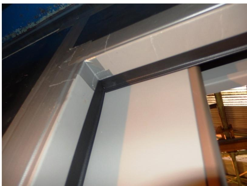
上枠及び召合せに設置した気密ゴム
