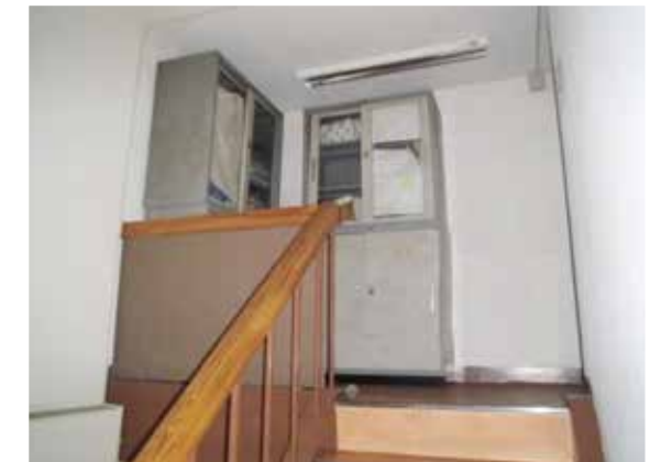
●塔屋階の物件存置状況
