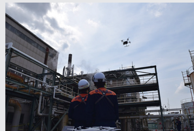
ドローン飛行状況
