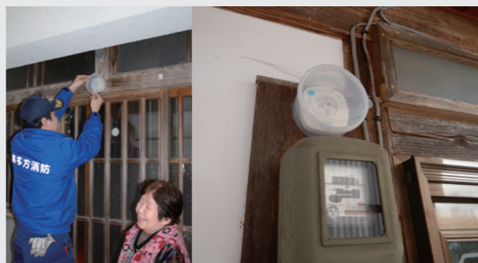
屋外警報装置設置作業 屋外警報装置
