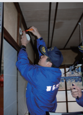
連動型住警器設置作業
