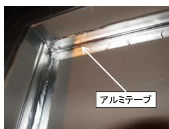
【図 3－3 7】戸下部の アルミテープ処理（裏面）
