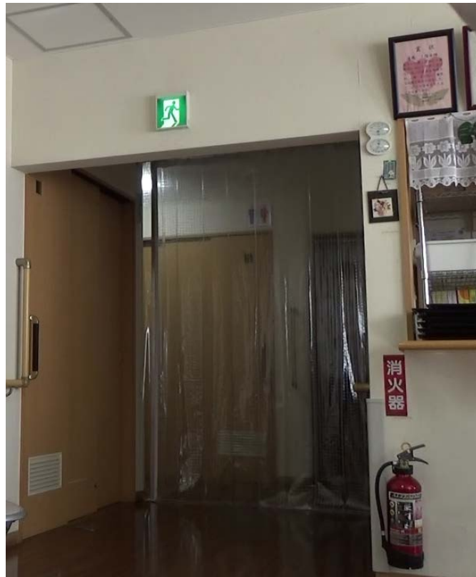
写真1 アコーディオンカーテン型の遮煙装置 (Case1, 4)
