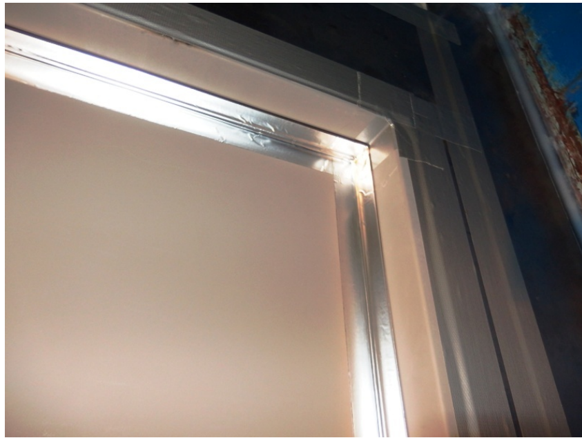
写真-16 試験体（鋼製吊り戸：表面アルミテープ処理仕様） 縦枠，上枠と戸の間にアルミテープ処理
