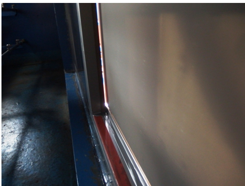
写真－6 試験体（鋼製吊り戸：標準仕様（気密材無し）） 召合せと戸の状況
