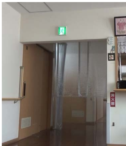
写真4 のれん型の遮煙装置 (Case3)
