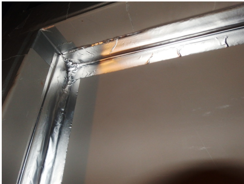
写真-17 試験体（鋼製吊り戸：表面アルミテープ処理仕様） 上枠，召合せと戸の間にアルミテープ処理
