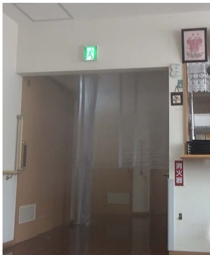
写真2 のれん型の遮煙装置 (Case3)
