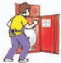
開閉弁を開放すると消火栓ポンプが起動します。
