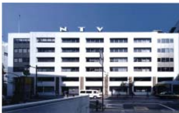
建物全景(補強後)
