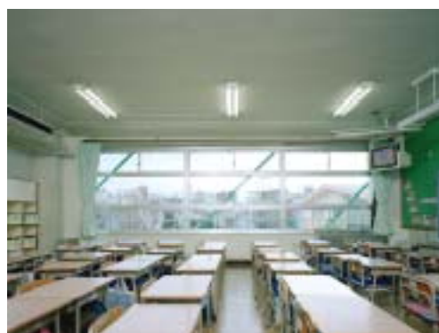
補強後の建物内観
