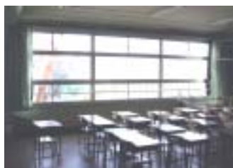
補強前の建物内観
